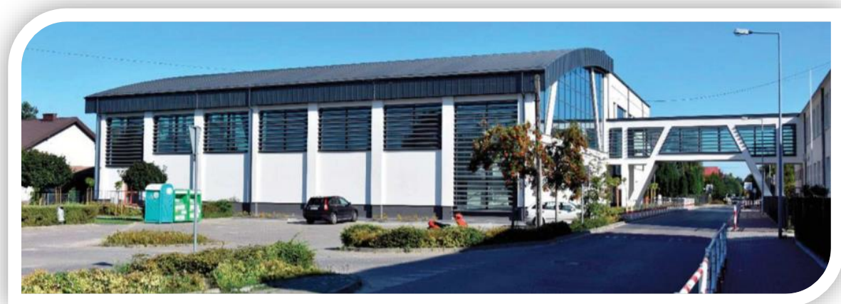
Nowa część szkoły – widok od strony hali sportowej i łącznika.
