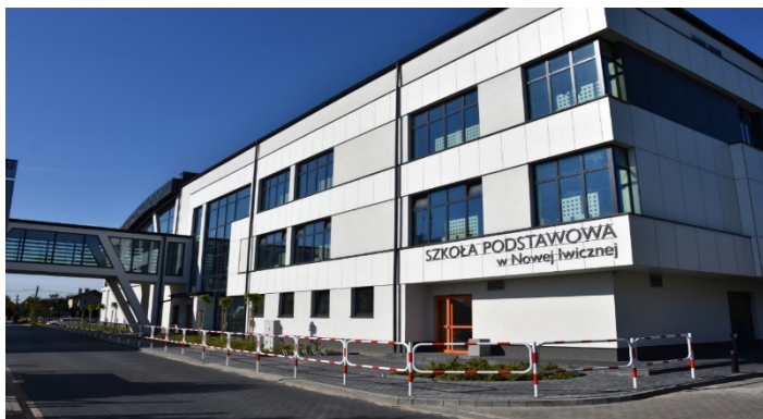
Fot. nr 3. Rzobudowana Szkoła Podstawowa w Nowej Iwicznej.
