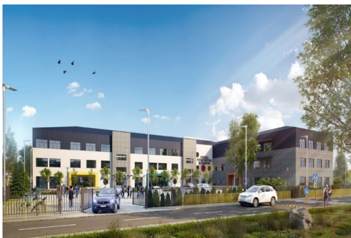
Fot. nr 4. Szkoła Podstawowa w Zamieniu – w budowie.
